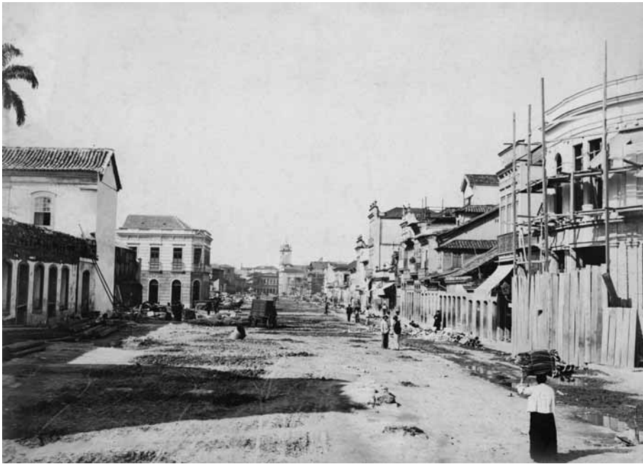
Obras de alargamento e junção das antigas “rua estreita” e “rua larga” de São Joaquim, rebatizadas como rua Marechal Floriano, c. 1904 Anônimo
