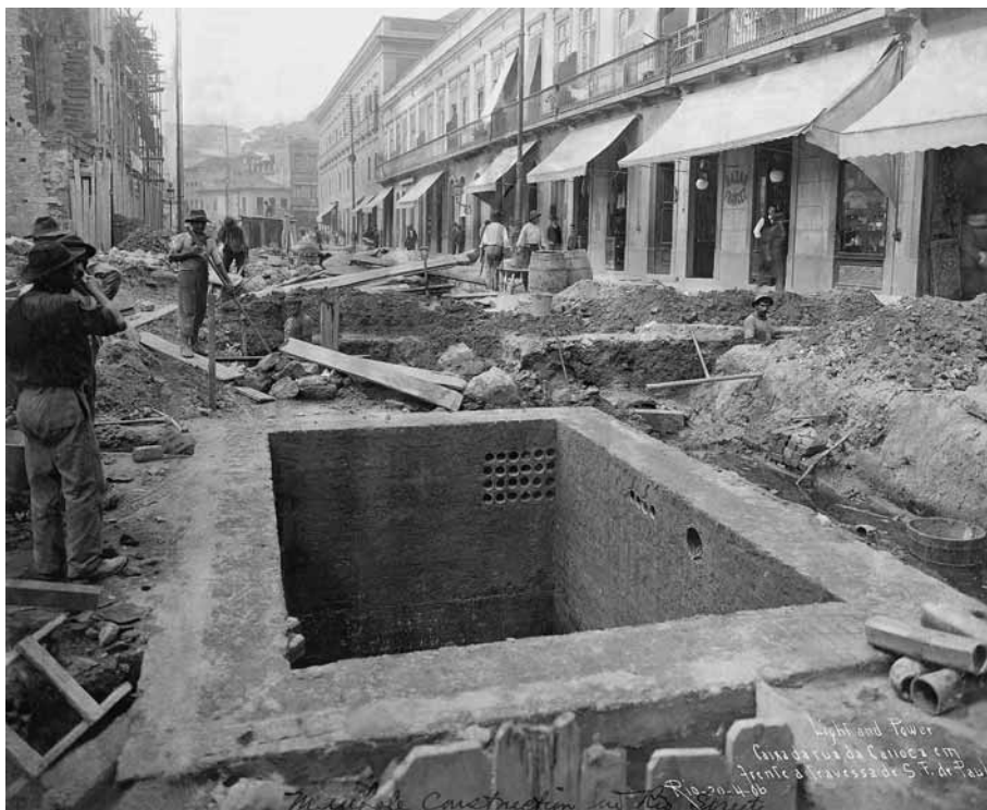
Obras de saneamento paralelas às demais medidas sanitárias. Caixa da rua da Carioca, em frente da travessa de S. Francisco de Paula, c. 1906
