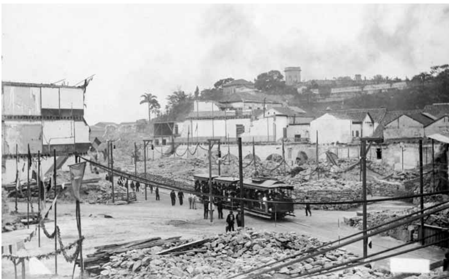
Linha de bondes instalada no percurso das obras da avenida Central, c. 1904 João Martins Torres
