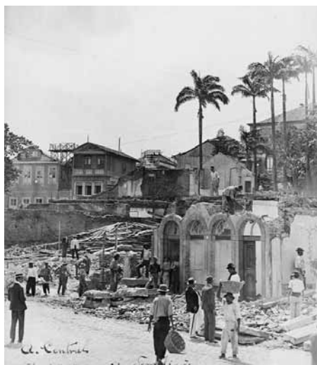
Demolições na encosta do morro do Castelo, 1904 João Martins Torres
