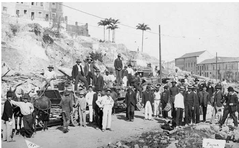
Demolições na encosta do morro do Castelo, 1904 João Martins Torres
